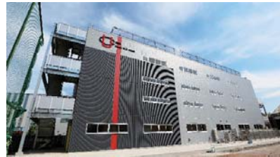
校舎及び2022年完成の第二体育館
